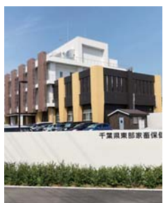
県東部家畜保健衛生所の外観
