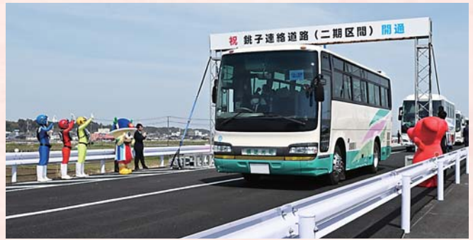
銚子連絡道路二期区間の開通
