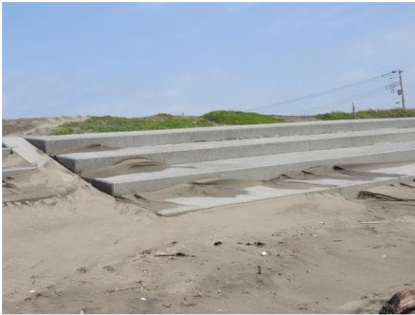
図 1 4 整備された防潮堤
