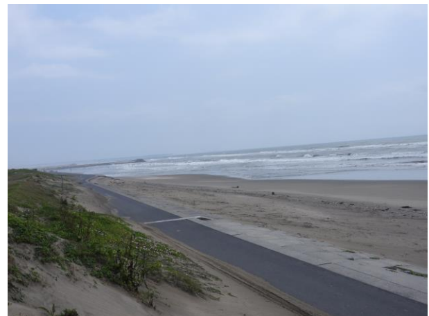
図 1 3 舗装された道路
