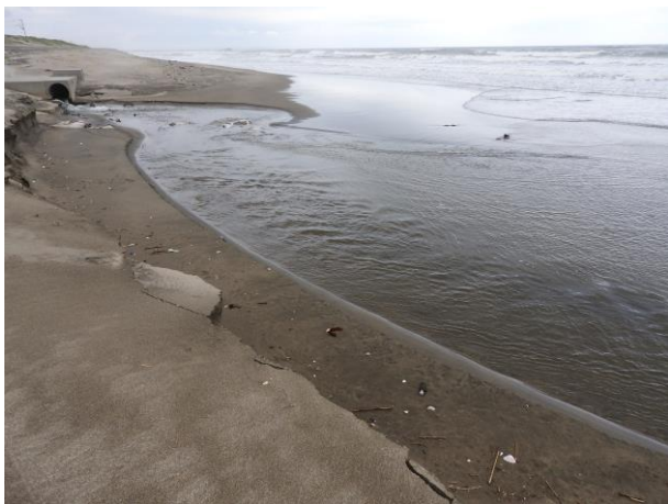
図 6 4 排水口の状況②
