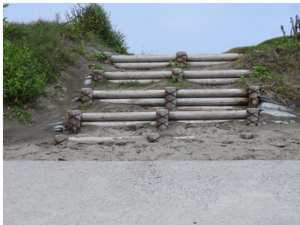
図 1 2 防潮堤に設置された階段
