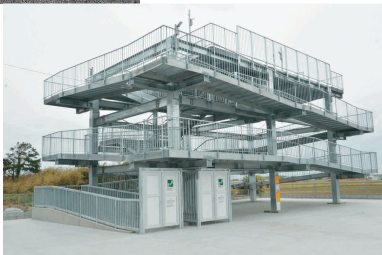
栄地区津波避難タワー
