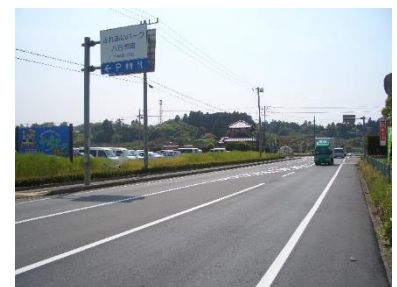
東総地区広域道路
