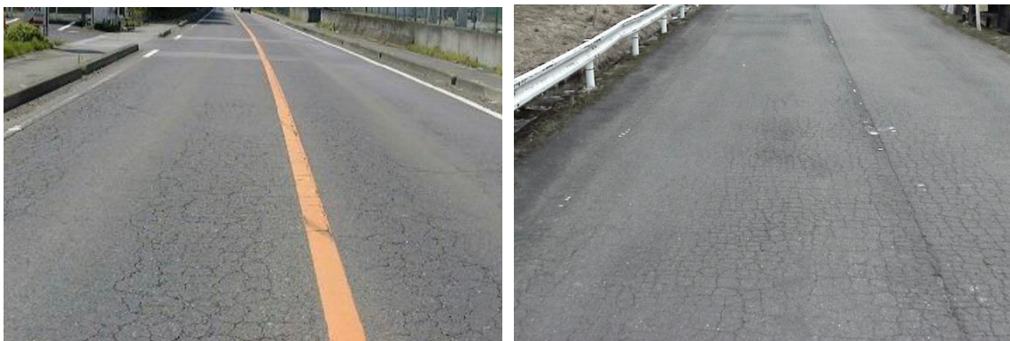
図 3-3. ひび割れ率 40%以上の舗装の目安
