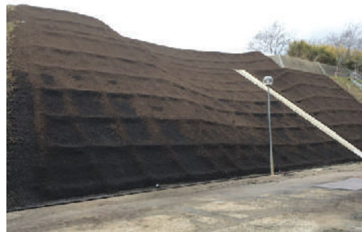
豪雨により崩れた法面の復旧状況（八日市場第二中学校）
