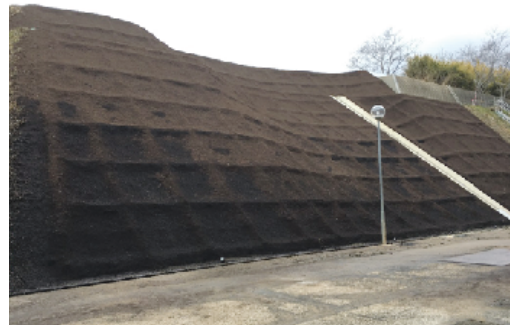
豪雨により崩れた法面の復旧状況（八日市場第二中学校）
