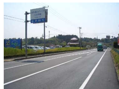
東総地区広域道路
