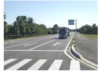
主要地方道 八日市場野栄線 (野栄バイパス)
