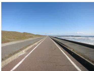
サイクリングロード (太平洋岸自転車道)
