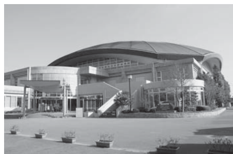
令和3年度、改修工事の行われる八日市場ドーム
