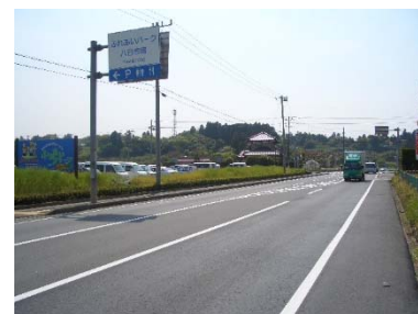
東総地区広域道路
