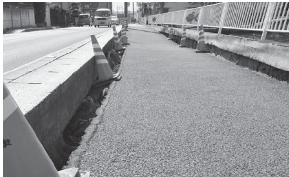
東日本大震災で陥没した歩道
