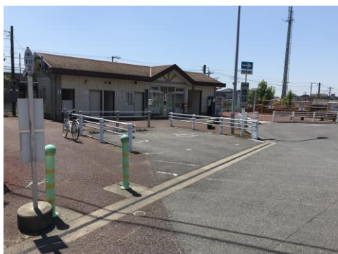
▲飯倉駅北口広場・全景
