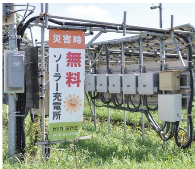
ソーラー発電設備による災害時の電力充電所
