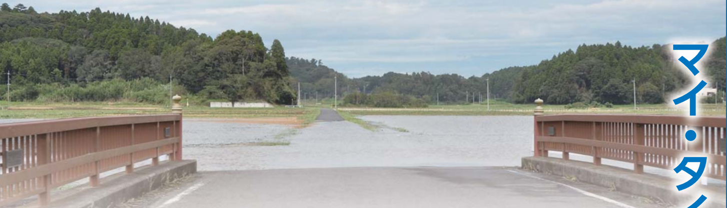
令和元年房総半島台風により冠水した道路
