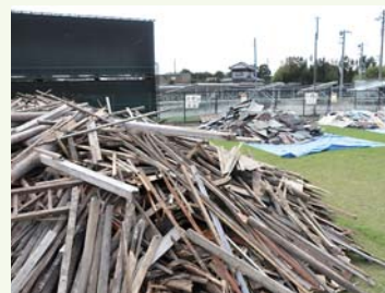
市営グラウンド下の仮置き場
