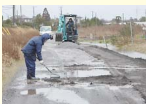
道路維持管理作業の様子
