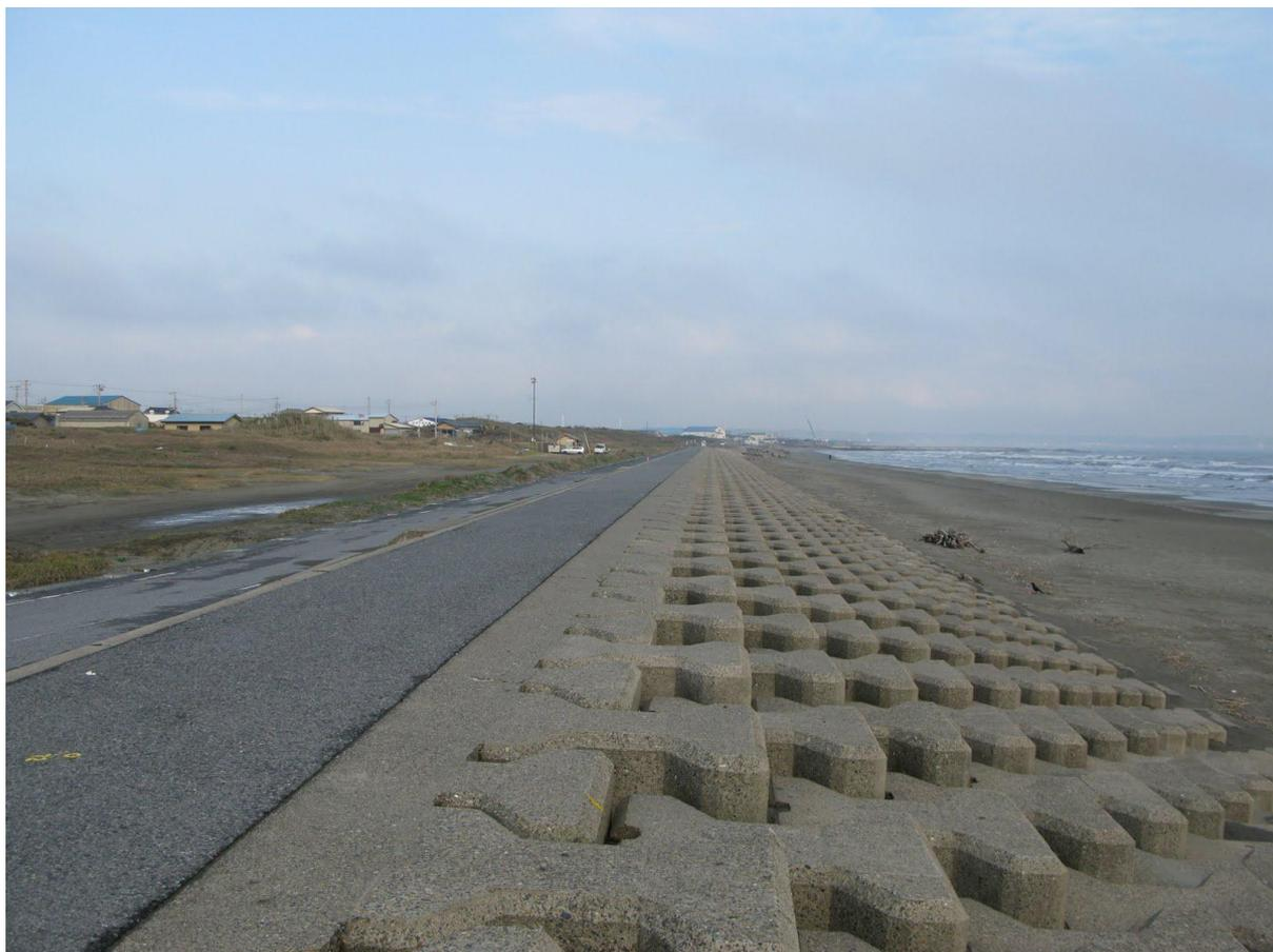
護岸は、水際線を構造物で固め、護岸で波力を弱め、陸地が波で削り取られないようにすることを目的とします。
