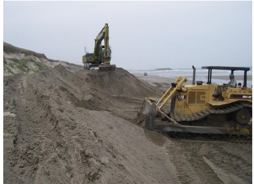
養浜工法とは、侵食された海岸において人工的に砂を供給し、波浪の軽減や海浜の回復などを目的とします。
