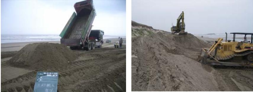
養浜工法とは、侵食された海岸において人工的に砂を供給し、波浪の軽減や海浜の回復などを目的とします。
