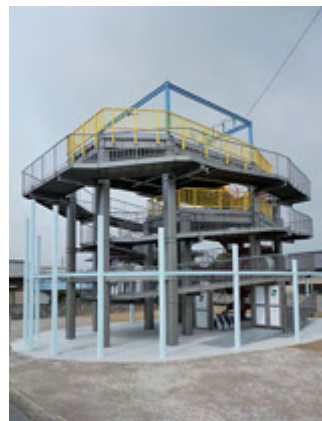
完成した津波避難タワー
