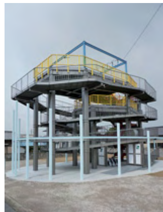
完成した津波避難タワー
