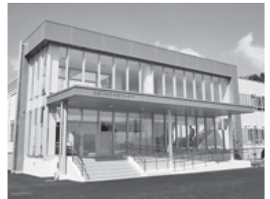
平成26年9月から給食の提供を開始した匠瑤市学校給食センター
