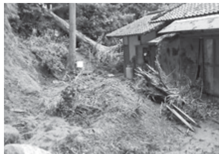
平成26年10月の大雨で発生した土砂崩れ（豊栄地区）
