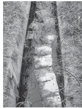
油吸着用マットが設置された水路
