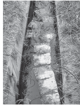
油吸着用マットが設置された水路
