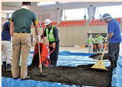
◀一輪車を使って土俵を覆う約8tの土を搬入 ▼「タタキ」や「タコ」といった道具で表面を仕上げていく
