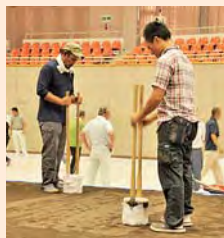
◀一輪車を使って土俵を覆う約8tの土を搬入 ▼「タタキ」や「タコ」といった道具で表面を仕上げていく
