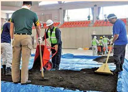
◀一輪車を使って土俵を覆う約8tの土を搬入 ▼「タタキや」タコといった道具で表面を仕上げている
