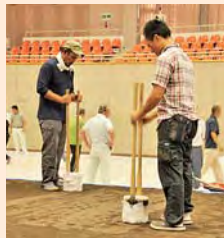
◀一輪車を使って土俵を覆う約8tの土を搬入 ▼「タタキや」タコといった道具で表面を仕上げている
