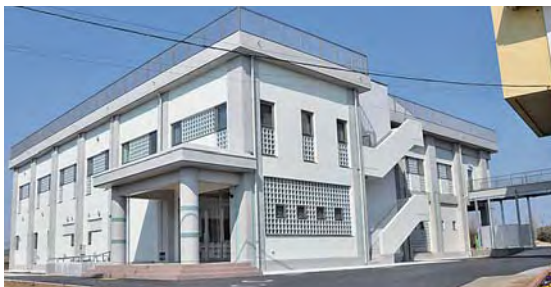
栄小学校体育館
