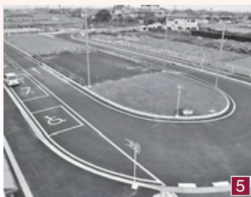
八日市場駅南側にロータリー整備
