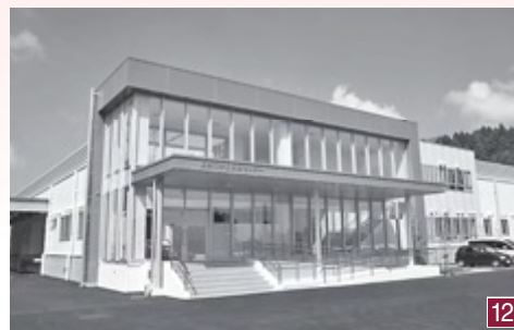
従来の2センターを統合して 新たに完成した匝瑳市学校給 食センター
