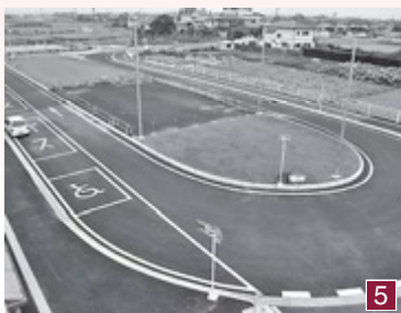
八日市場駅南側にロータリー整備
