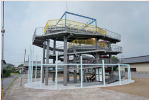
今泉地先に整備した津波避難タワー（7月）
