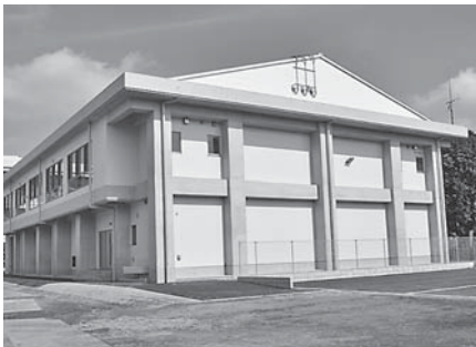
29年2月に竣工を迎えた吉田小学校屋内運動場
