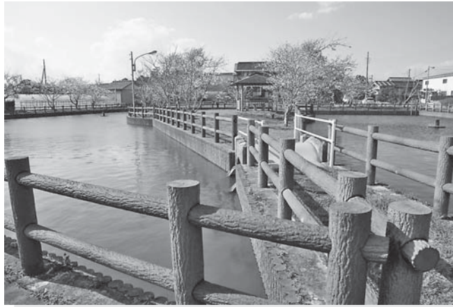
かつて野手城のあった場所に作られた弁天池。中の島に弁財天がまつられている
