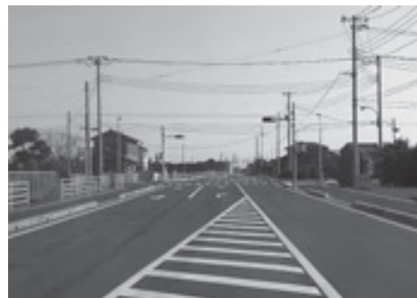
開通した野栄中学校付近
