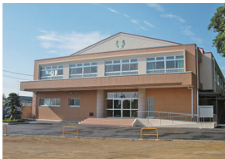
完成した八日市場小体育館
