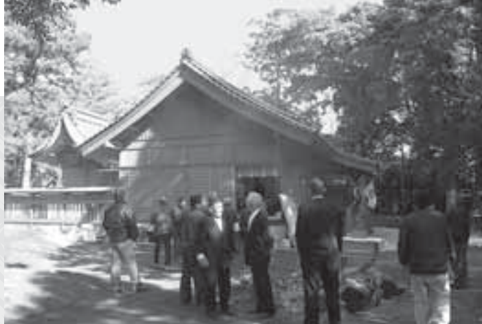
改修・新築された稻生神社の本殿と拝殿
