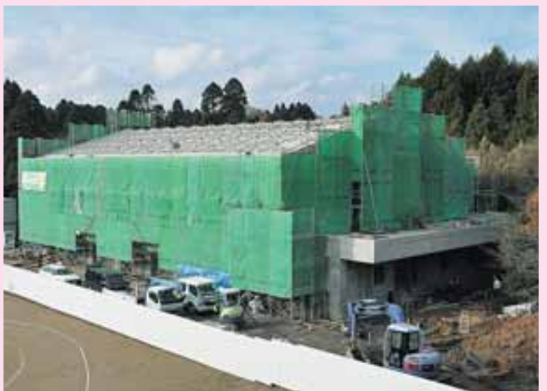
完成が待たれる豊栄小学校屋内運動場
