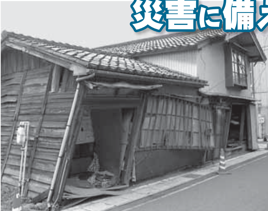
平成19年新潟県中越沖地震による住家の被害 (財団法人消防科学総合センター提供)
