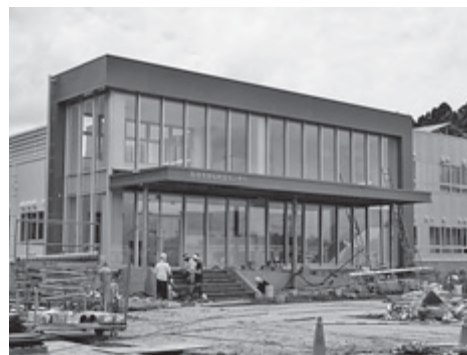
建設が進む匝瑳市学校給食センター
