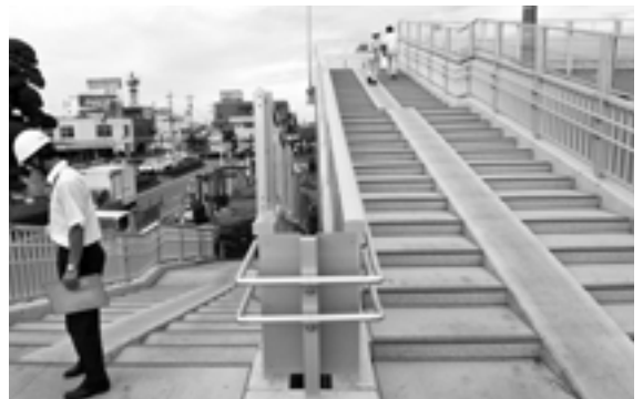
斜路付階段 自転車での利用ができるよう中央にスロープ（幅 60cm）が付けられています
