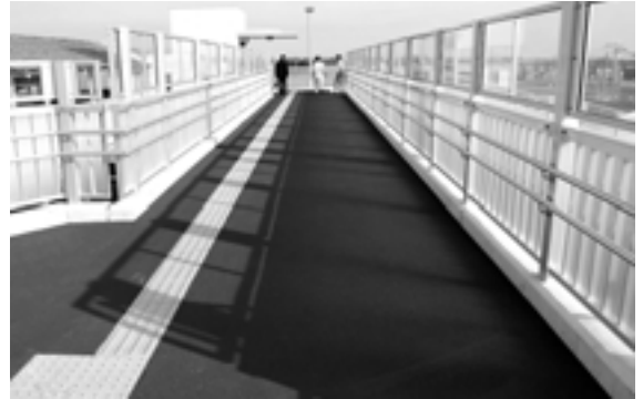
自由通路中央部分 目の不自由な方でも自由通路を利用できるよう、 南北のエレベーター間をバリアフリー化し、点字 ブロックを設置しました
