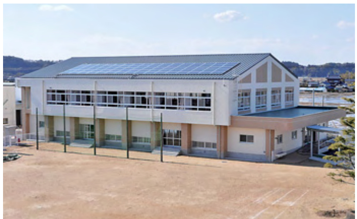
太陽光パネルを設置した体育館
