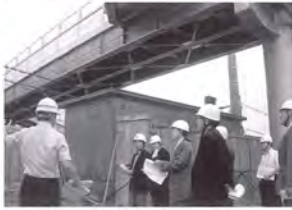
完成前の八日市場駅自由通路
