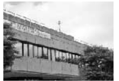
▲野栄支所の屋上に設置されている防災無線
