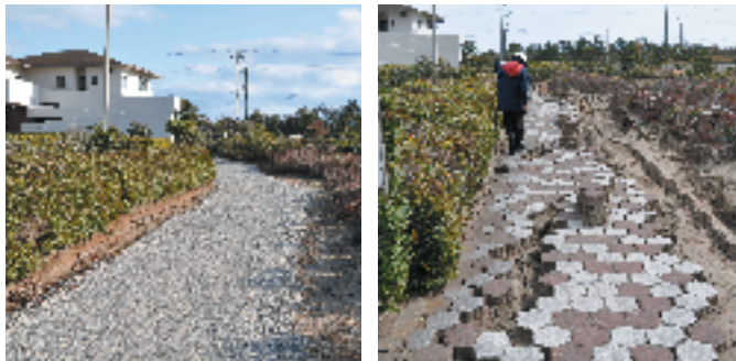
野外活動施設の通路 (右:震災直後 左:復旧後)
