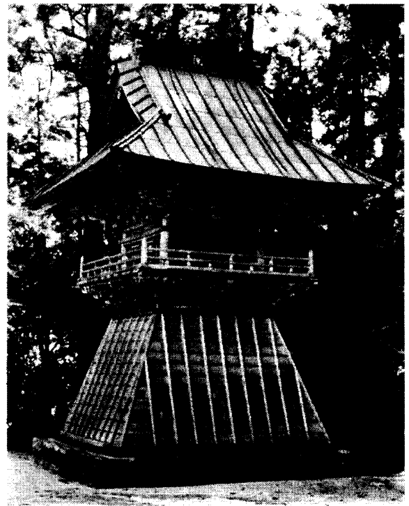
10 修理前 西北面
